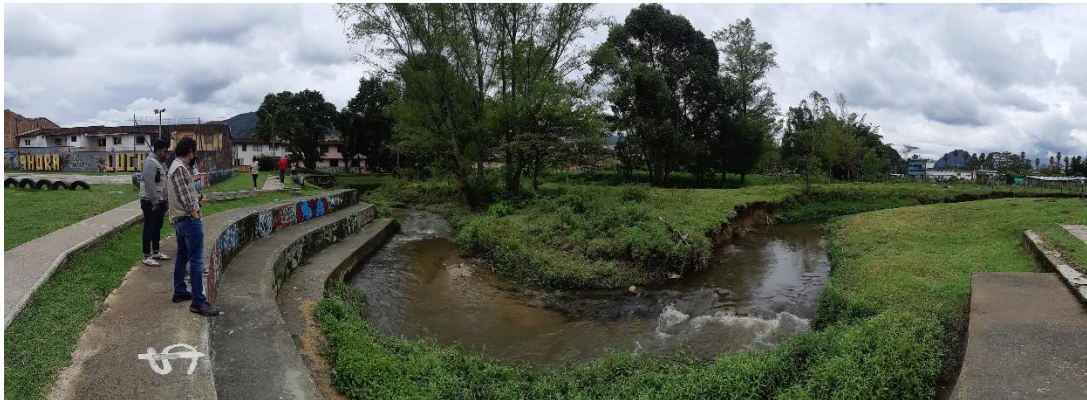
Figura 51. Obras de mitigación por erosión en La Ceja, quebrada La Pereira
